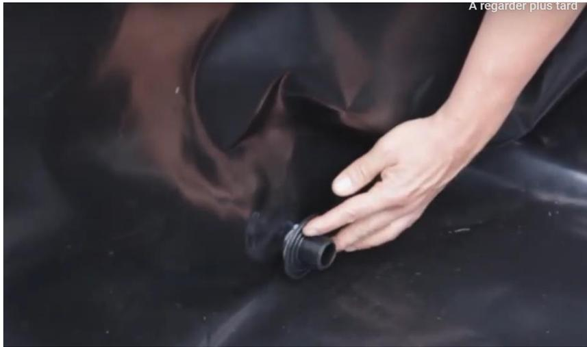
Il faut veiller à ne pas faire de plis dans la bâche quand on fixe les deux joints d'étanchéité. Le passe-paroi est vissé des deux côtés, ainsi que l'embout coudé et le tuyau PVC rigide. On peut rajouter du ruban téflon pour fixer le trop-plein à l'extérieur. A ce stade, on peut finir d'agrafer le restant de la bâche.
